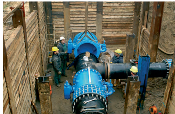
Baustelle für Wasserleitung in Leipzig
