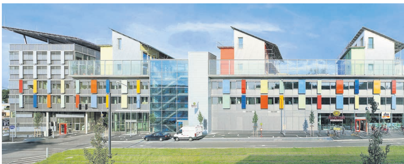
Umweltfreundlich und funktional: Immobilien, die mehr Energie erzeugen als sie benötigen, sind keine Utopie, wie das Beispiel der Solarsiedlung in Freiburg zeigt.
